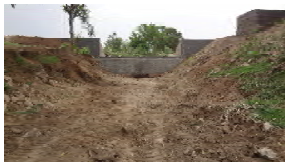
ग्राम बछौनी में निर्मित संरचना (झाप तथा गेजिंग स्टेशन)
