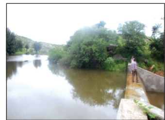
Masonry check dam at Som
