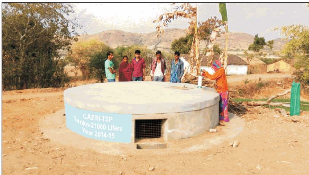
चित्र 4.2. बरनिया जलग्रहण परियोजना में 21000 लीटर क्षमता वाले 3 वर्षाजल संग्रहण टांकों का निर्माण Fig 4.2 Rainwater harvesting tanks of 21000 liters capacity at Bernia watershed ( Dungarpur )
