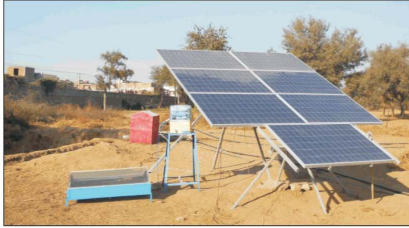
चित्र 8.5 सोलर पम्प की परिवर्तनीय बिजली बटन द्वारा चालित विपरीत परासरण एवं सोलर विलवणीकरण पद्धति आधारित पानी शुद्धीकरण प्रणाली Fig 8.5 Water purification system through RO and solar desalination device under change over switching facility of solar pump
