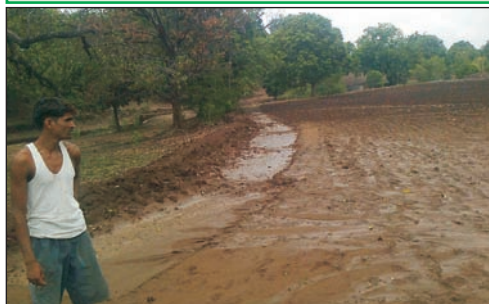
Trench cum bunding
