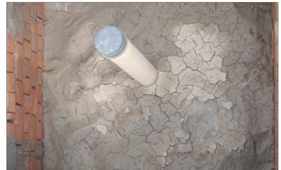
चित्र 3. अवसाद के कारण अवरुद्ध रेत, बजरी एवं पत्थरों वाली छन्नक ईकाई
