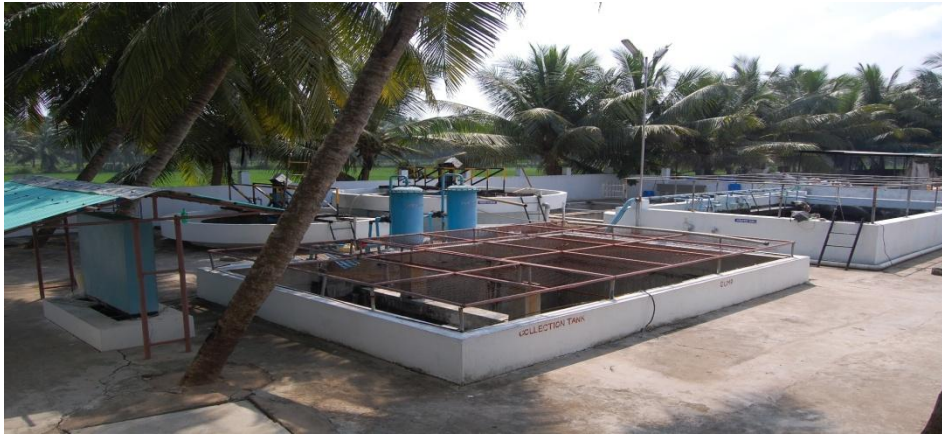
Fig: 06-Effluent treatment area
