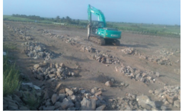
गड्ढे का निर्माण
