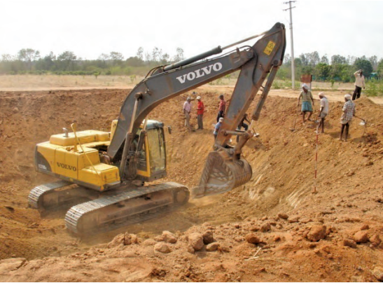
పటం 13. డగౌట్ ఫార్మ్ పాండ్ లో V బండ్ మోడల్లో భూమి త్రవ్వకాల యొక్క దృశ్యం
