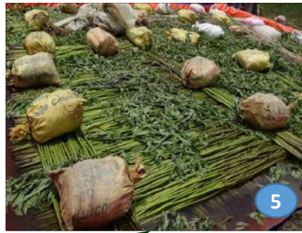
5. जाक को जलमग्न करने के लिए जाक के ऊपर सीमेंट की थैली में लोड (रेत / पत्थर / मिट्टी आदि) का प्रयोग
