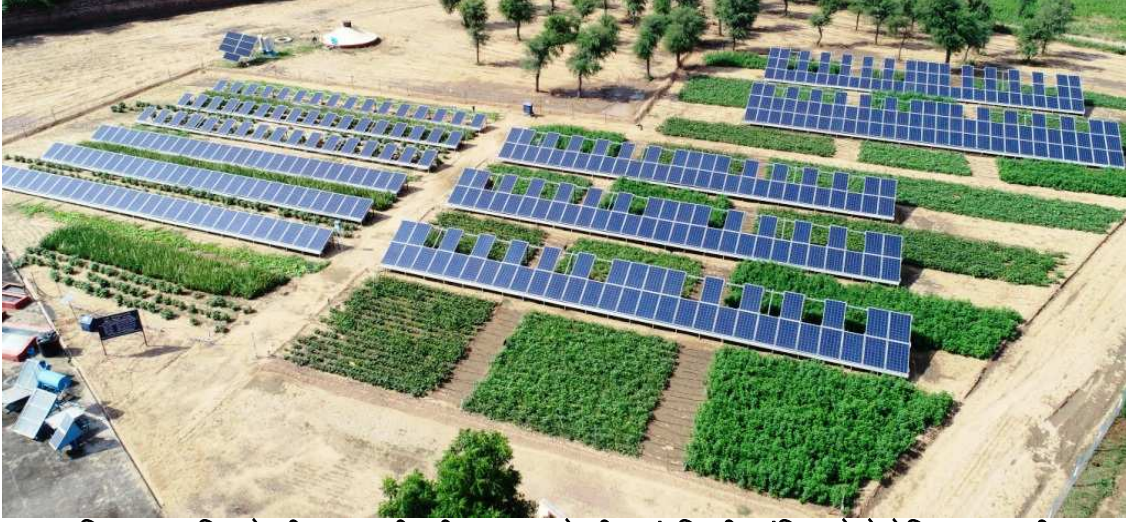
चित्र 2: कृषि-वोल्टीय प्रणाली की एकल, दोहरी एवं तिहरी-पंक्ति फोटोवोल्टिक सारणी
